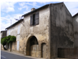
Façade de la troisième auberge, située au 6 rue Chemin de St-Jacques
