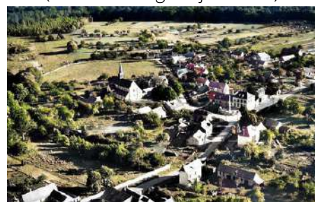
2007-vue aérienne (nord-ouest) de la rue du centre du village (rue du Marais au premier plan)
