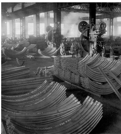
( Atelier des cadres de mine )
