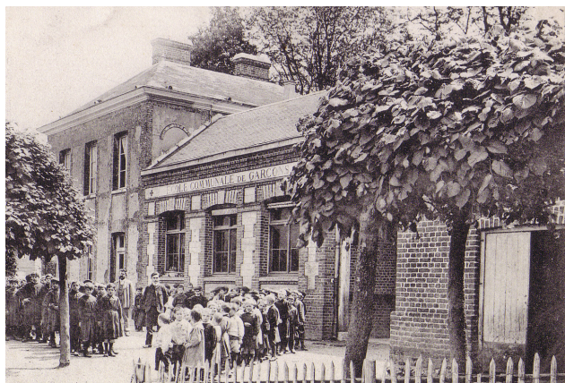
Mairie - école de garçons (Croisement Route de Lyons - Rue des villages)
