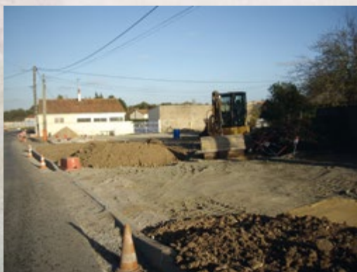
Travaux de Puyraveau
